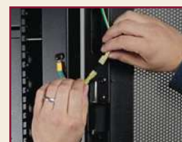
Cables de liberación rápida a tierra
